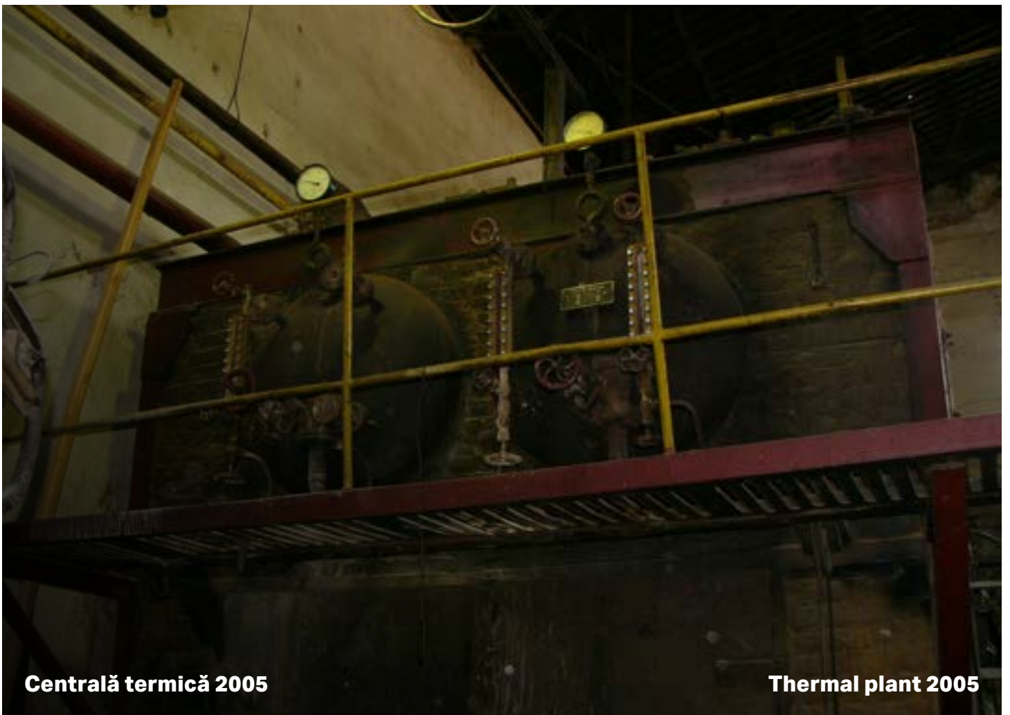
Cazan apă supra încălzită cu generator electric
